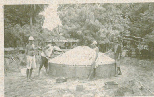
Processo de construção de cisterna de placa na comunidade Violeta, São Gonçalo do Amarante
