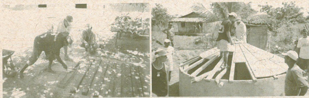
Processo de construção de cisterna de placa na comunidade Violeta, São Gonçalo do Amarante
