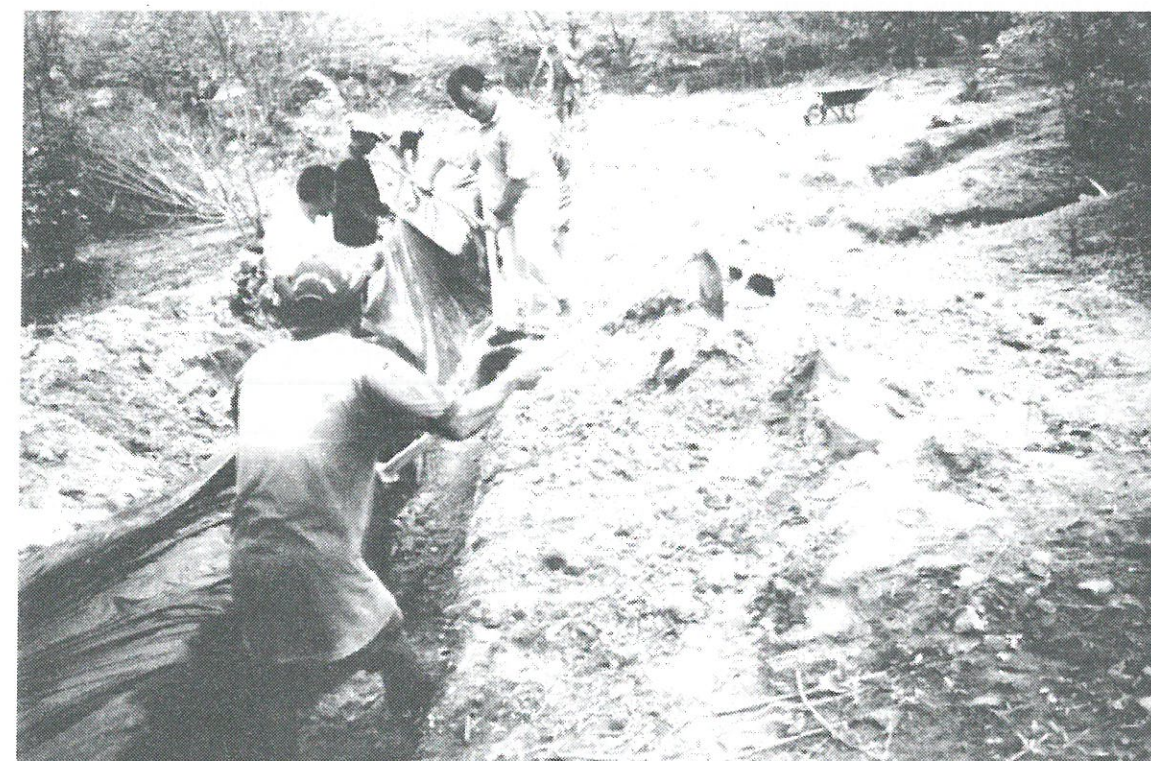
Construção da barragem subterrânea em Nova Conquista/Amontada - Dezembro de 2003
