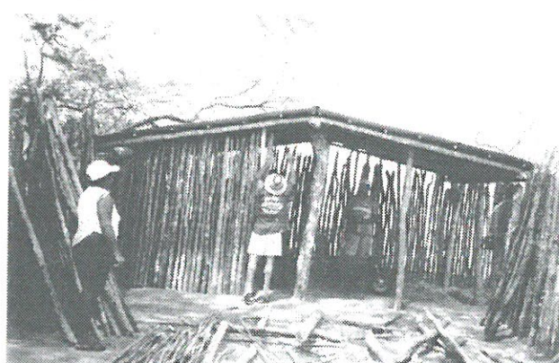
Construção da unidade demonstrativa de galinha caipira em Recreio/Quixeramobim - Novembro de 2003
