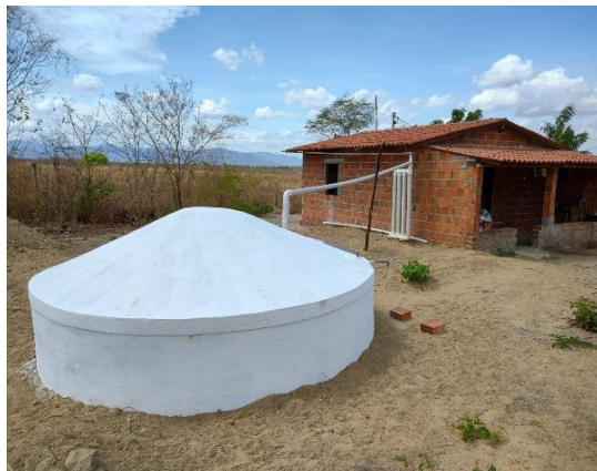
Figura 4. Cisternas de placa de 16 mil litros - Tecnologia social de captação de água de chuva para consumo humano.
