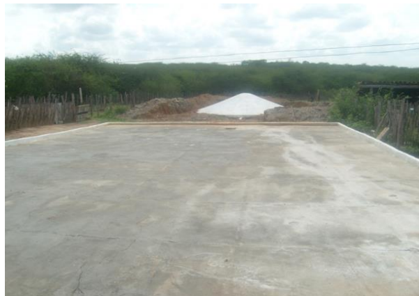
Figura 5. Cisterna calçadão de 52 mil litros Tecnologia social de captação de água de chuva para produção de alimentos.
